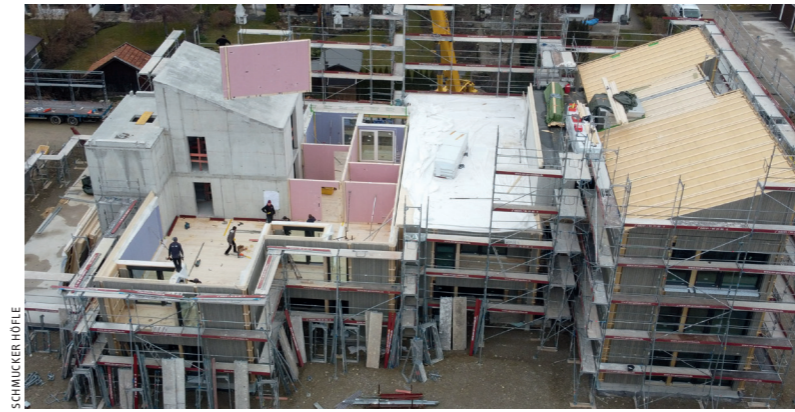
◀ Die Innen- und Außenwände wurden schon fertig beplankt zur Montage angeliefert
