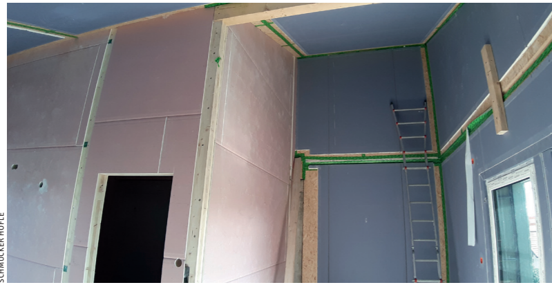
◀ Auch die Installationsverrohrung wurde bereits im Werk in die Wände integriert
